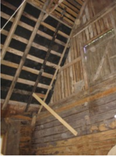
9: Lagunenud katuse ajutine toetus 10: Lagunev sein ja katus pargi poolt 11: Lagunev sein ja katus tee poolt
