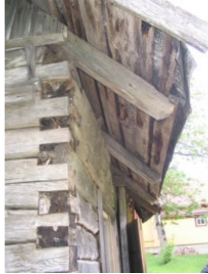
9: Lagunenud katuse ajutine toetus 10: Lagunev sein ja katus pargi poolt 11: Lagunev sein ja katus tee poolt
